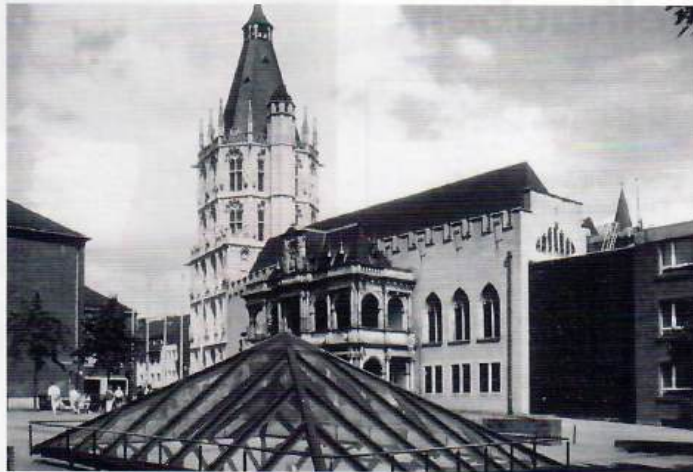
Das Kölner Rathaus. Im Vordergrund das Schutzdach über dem von etwa 1170 stammenden jüdischen Kultbad, der Mikwe.
